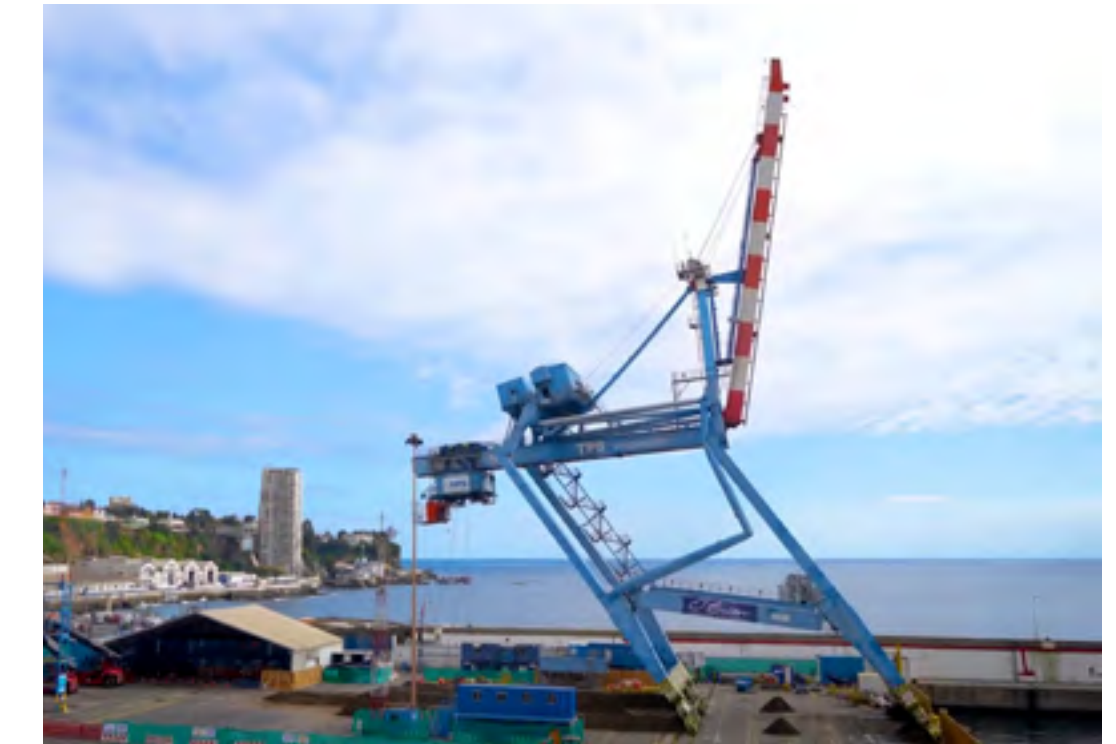
Colapso controlado grúa pórtico 1.
